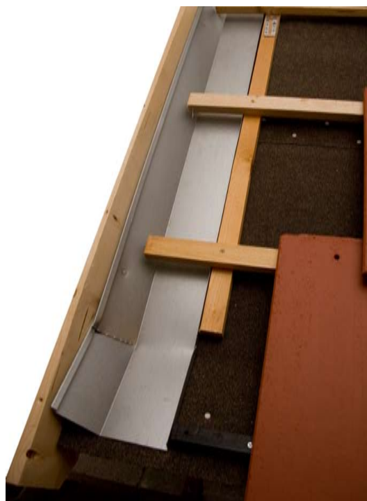
Bild 2: Dold avrinningsplåt montering
